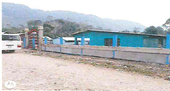
Foto 1: Se observa el muro perimetral que esta siendo remozado
