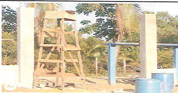
Foto 5: Se observa los trabajos de remozamiento en el porton
