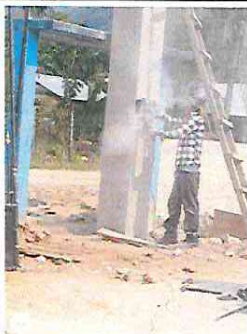
Foto 3: Se observa la reparacion de la base del porton
