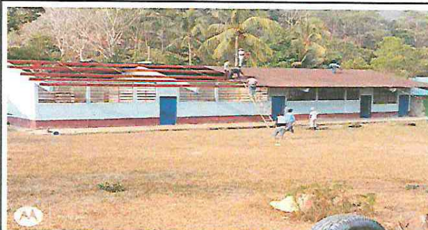
Foto 6: Se observa el cambio de lamina del establecimiento
