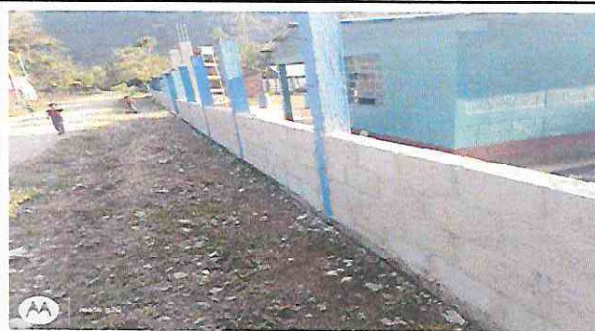
Foto 2: Se observa el muro perimetral que esta siendo remozado
